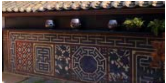
보전처리 공사 후 꽃담서울생활문화센터 체부의 모습
