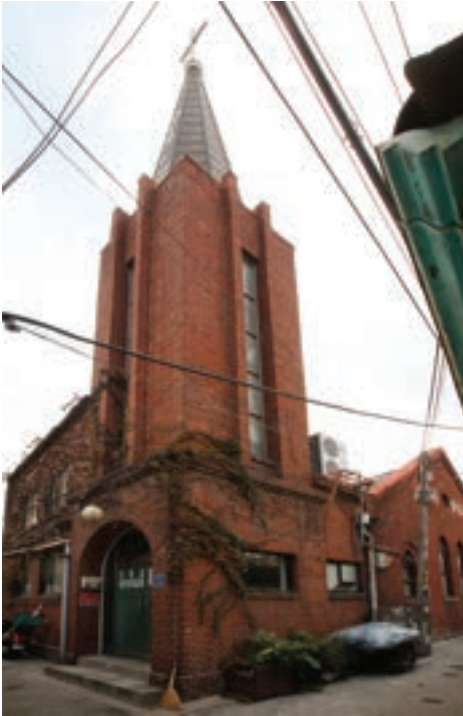
리모델링 이전 체부동 성결교회
