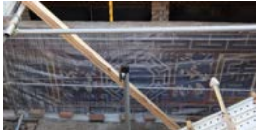
리노베이션과 병행한 보전처리 작업
